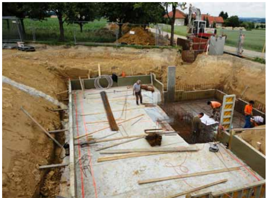
Die Bauarbeiten schreiten zügig voran
