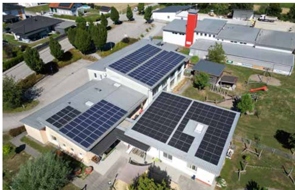
Erweiterung der Photovoltaikanlage auf dem Kindergarten Dach
